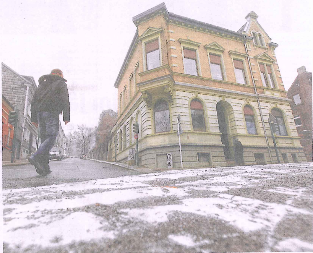
Spätestens im April werden die Sanierungsarbeiten am Haus Propsteistraße 36 beginnen.
